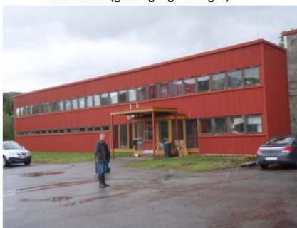
Joma kontor (gruvningång till höger)
