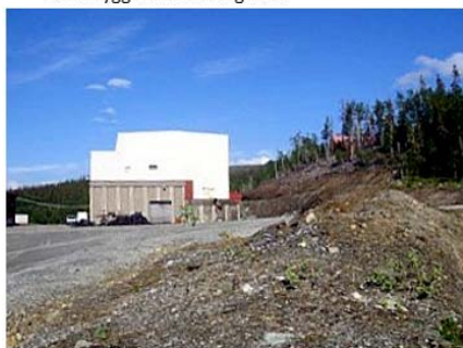
Joma byggnad anrikningsverk
